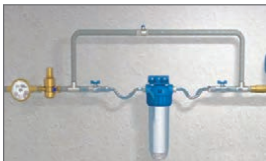
شکل ۶- روش نصب سختی گیر پلی فسفات
