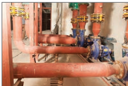
شکل ۳۳- خط مکش پمپ زمینی
