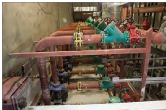
شکل ۳۳- خط مکش پمپ زمینی
