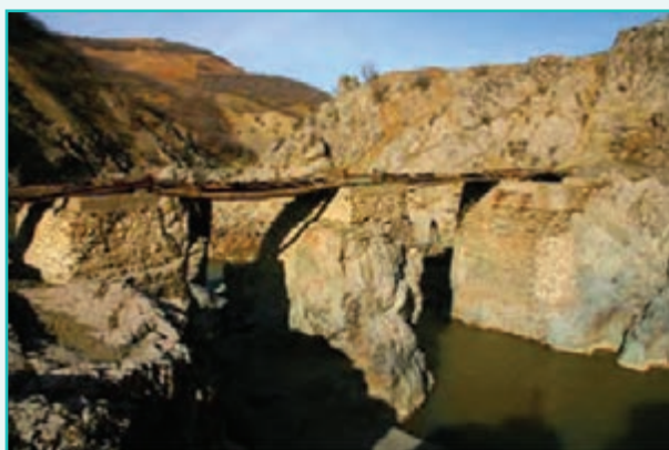
شکل ۲۷-۵- پل قلاتاسیان سردشت
