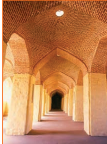
شکل ۲۳-۴- نمای از داخل مسجد جامع ارومیه
