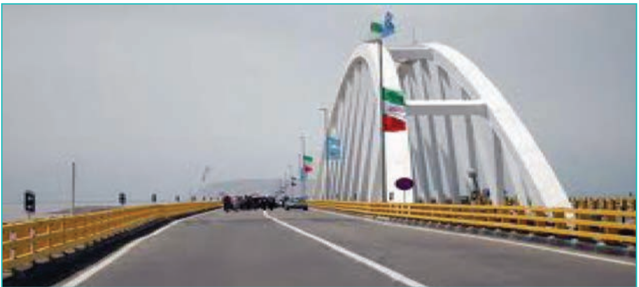
شکل ۶-۶ - پل میان گذر دریاچه ارومیه
