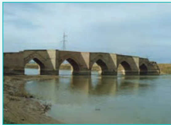
شکل ۲۶-۵- پل میرزا رسول در میاندوآب
