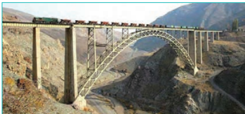
شکل ۶۶-۵- پل هوایی قطور- خوی
