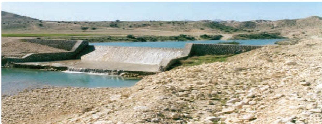
شکل ۱۳-۱۴ احداث استخرهای ذخیره آب
