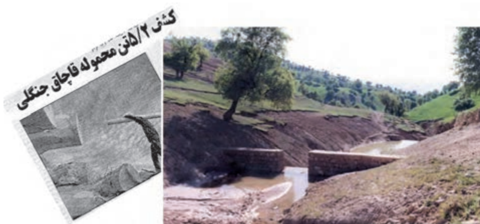
تصویر ۴-۱۵- اجرای طرح‌های آب‌خیزداری جهت کنترل سیلاب
