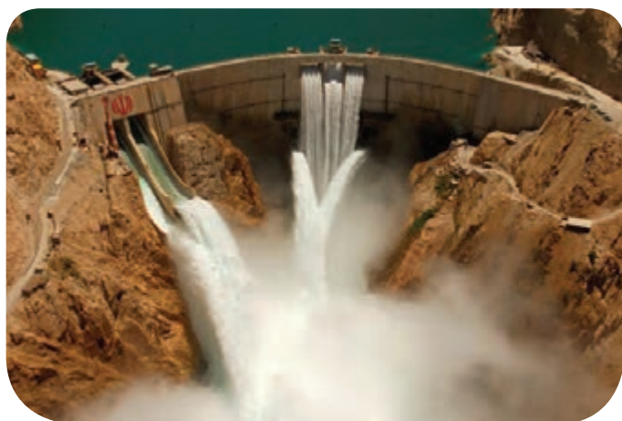
شکل ۳- سد و نیروگاه آبی کارون ۳ استان خوزستان
