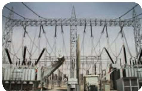
شکل ۱۷- پست انتقال برق
