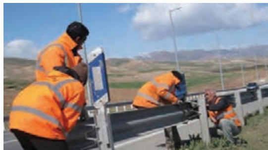
شکل ۷- نصب گاردریل کنار راه
