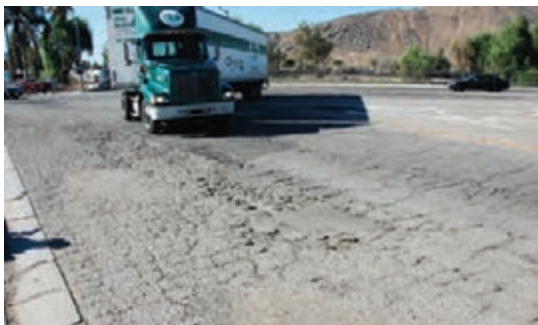
شکل ۱۲- نمونه‌هایی از خرابی‌های روسازی ناشی از ترمز یا وزن زیاد وسایل نقلیه سنگین
