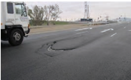
شکل ۱۲- نمونه‌هایی از خرابی‌های روسازی ناشی از ترمز یا وزن زیاد وسایل نقلیه سنگین
