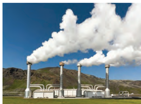
شکل ۱۱-۶- نیروگاه زمین گرمایی مشکین شهر - اردبیل
