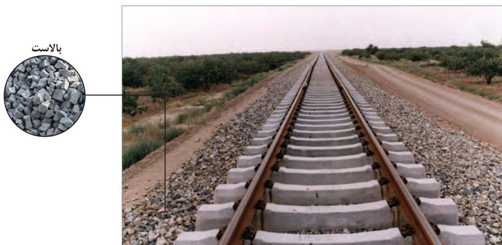
شکل ۴-۱۱- بالاست در زیرسازی جاده ریلی
