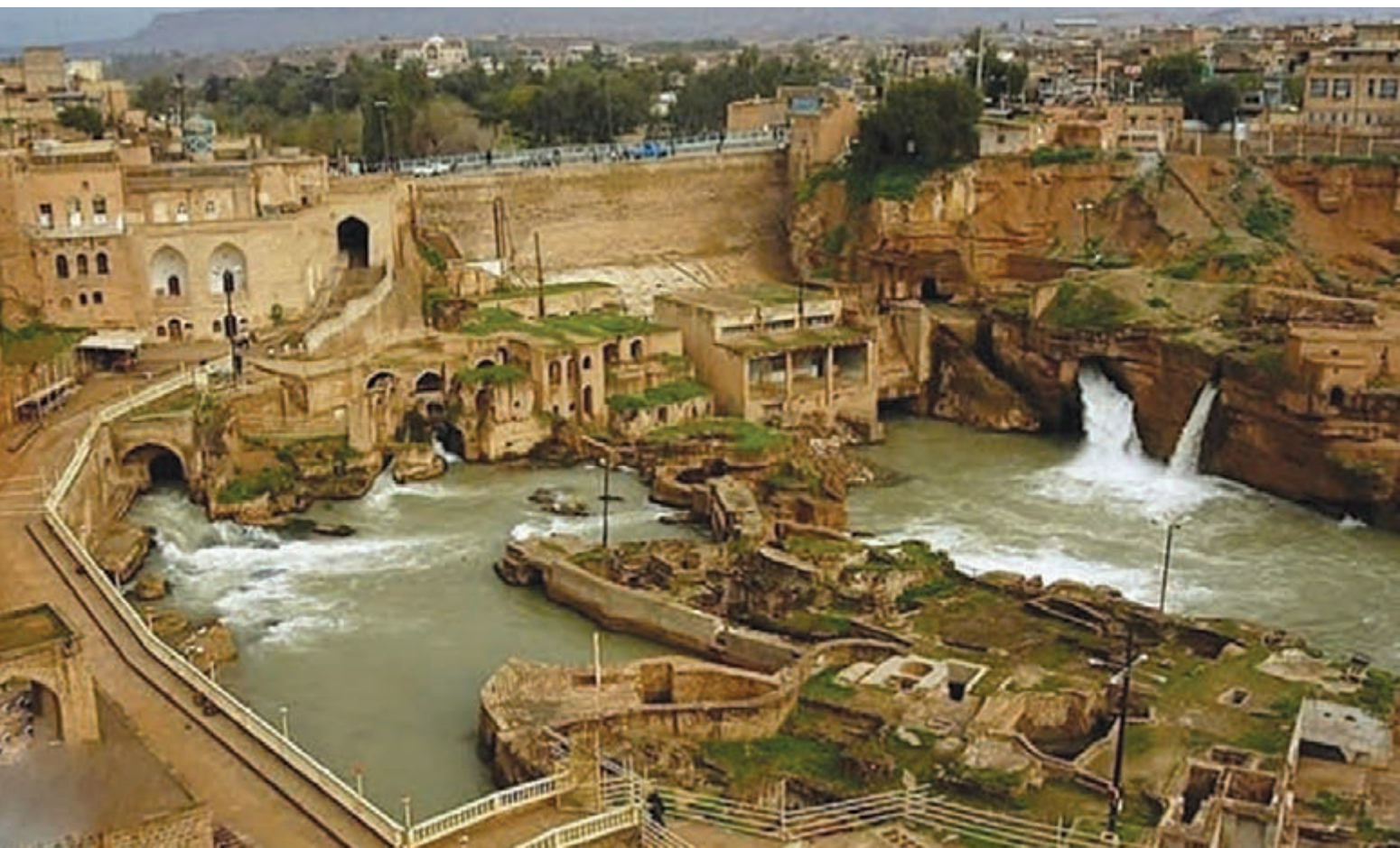
شکل ۵- سازه‌های آبی - تاریخی، شوشتر، خوزستان
