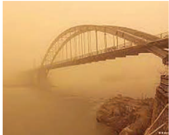
شکل ۳- الف) آلودگی ناشی از ریزگردها- اهواز
