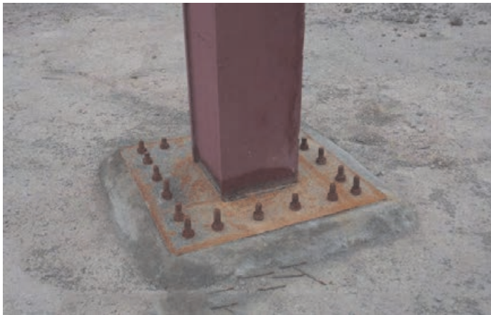
شکل ۴۹ ▲ اتصال مستقیم ستون به کف ستون
