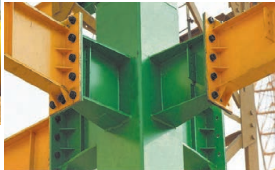
شکل ۵۰ ▲ انواع اتصال فلنجی
