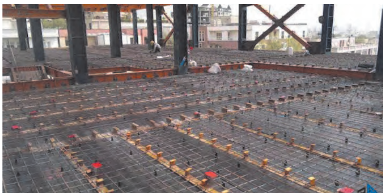
شکل ۳۲ ▲ سقف مرکب به همراه برشگیرها
