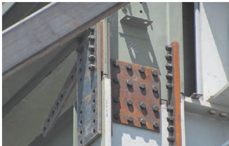
شکل ۵۷ وصله پیچی ستون
