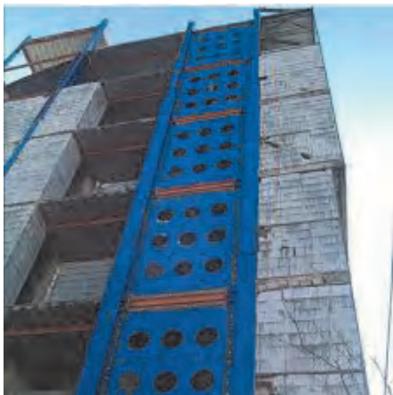
شکل ۶۱ ▲ دیوار برشی فولادی
