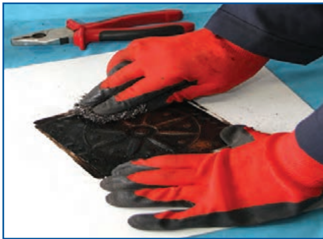
شکل ۱۱-۱۱- ساب زدن سطح پلاک مسی
