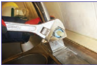
ث- باز کردن پیچ روی مغزی (گلند)
