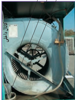
الف- نمای سمت پمپ کولر آبی
