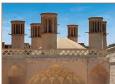
الف- استفاده از آجر در ساختمان‌های قدیمی
