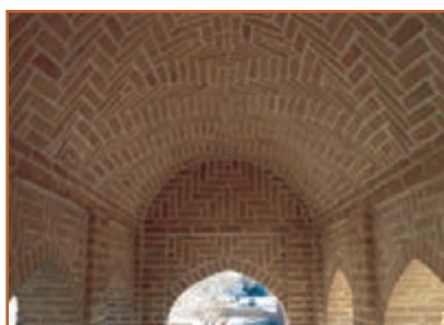
ب- استفاده از آجر برای سقف قوسی
