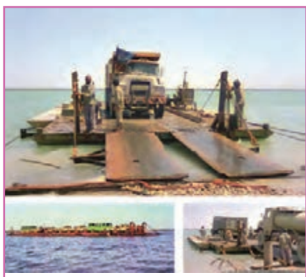
شکل ۱۸-۳- تصاویری از پل خضر
