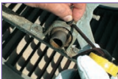
ث- روغن‌کاری یاتاقان‌ها
