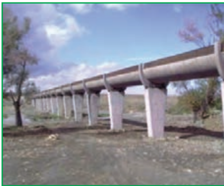
شکل ۱-۴۵ – کانال انتقال آب (سیاه کمر)
