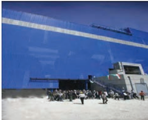
شکل ۱۸-۵- مجتمع فولاد ویان - کبودرآهنگ
