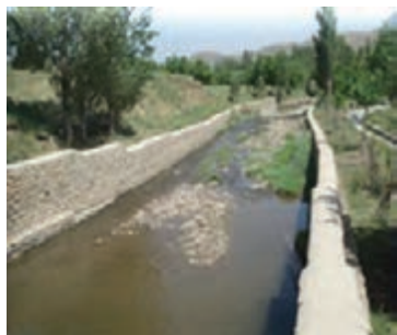
شکل ۱-۶۴ دیوار حاشیه رودخانه
