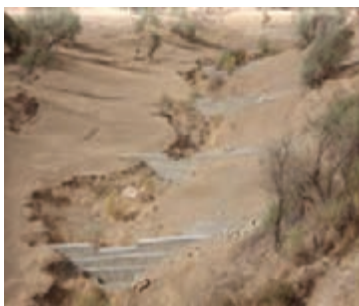
شکل ۱-۶۳ بند گابیونی (سنگ‌ها در تور سیمی)
