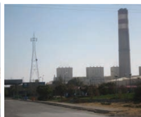
شکل ۱۹-۵- نیروگاه برق شهید مفتاح - فامنین
