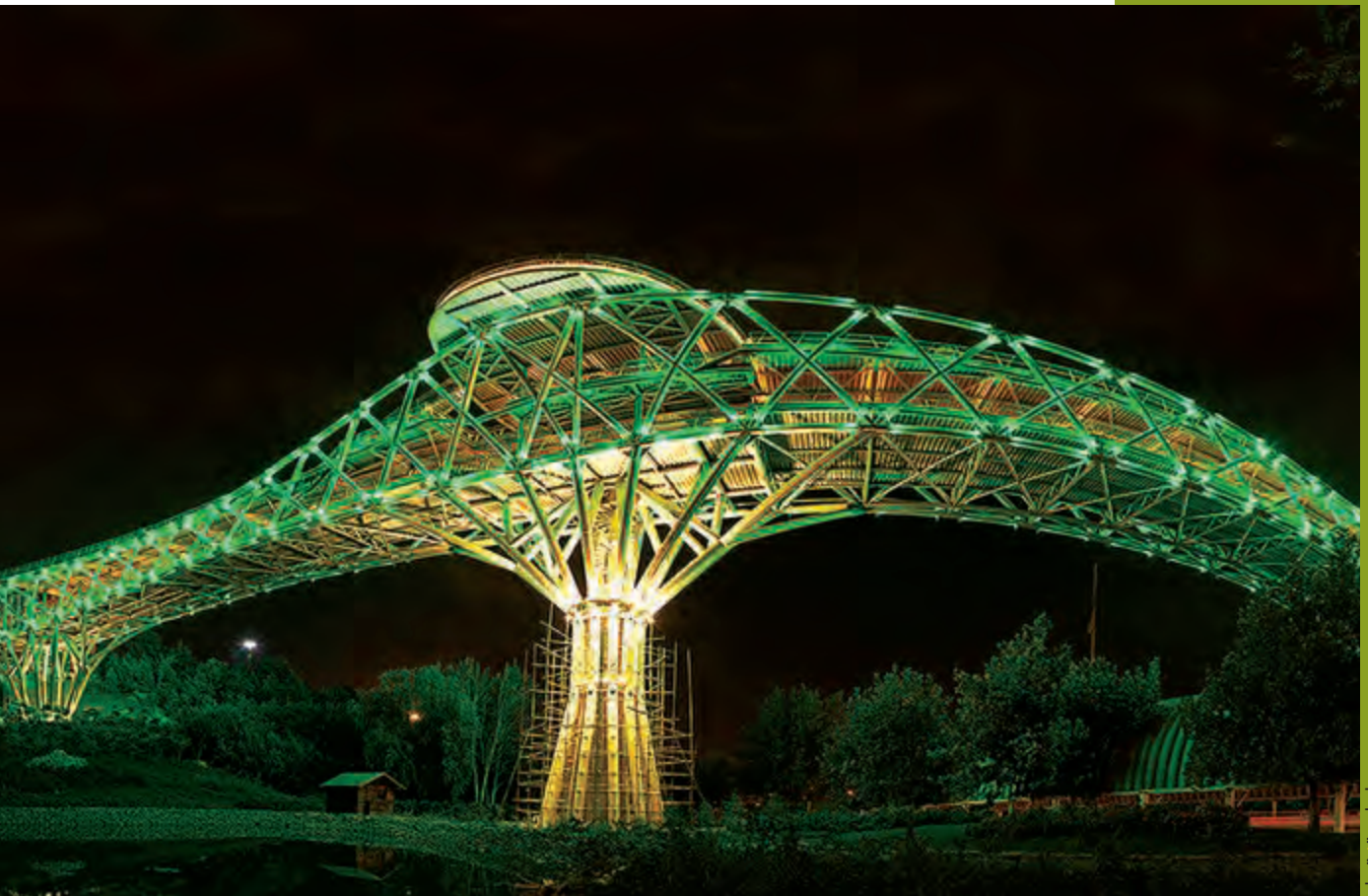
پل طبیعت - تهران
