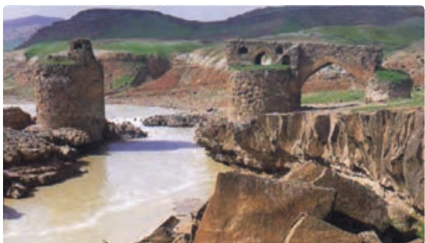
شکل ۲۹-۵- پل گاومیشان دره شهر
