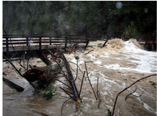
تخریب پل در اثر سیلاب منطقه تنگ کینشت، استان کرمانشاه مسدود شدن دهانه پل با تنه و شاخ و برگ درختان موجب سرریز شدن سیل و تخریب پل می شود.
