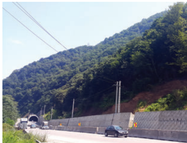
نصب حفاظ بتونی - جاده قائم‌شهر
