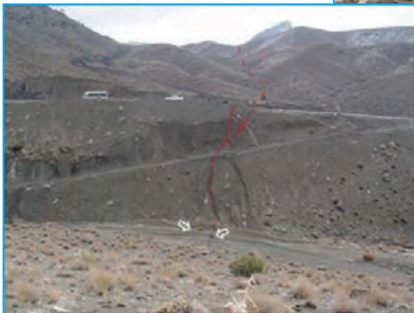
شکل ۲۵-۱- شکاف ناشی از زلزله داهونیة زرنده سال ۱۳۸۳
