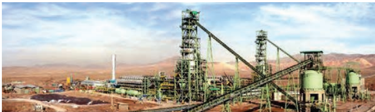
شکل ۳-۶- نمای از کارخانه فولاد خراسان - نیشابور
