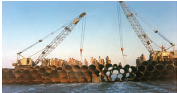
شکل ۱۵-۴- پل بعثت در داخل اروندرود، سند افتخار نیروهای مهندسی رزمی جهاد سازندگی
