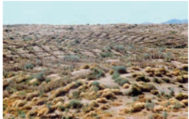
شکل ۴۵-۱ تپه‌های ماسه‌ای بعد از تثبیت (با احداث بادشکن شطرنجی و بذرپاشی)
