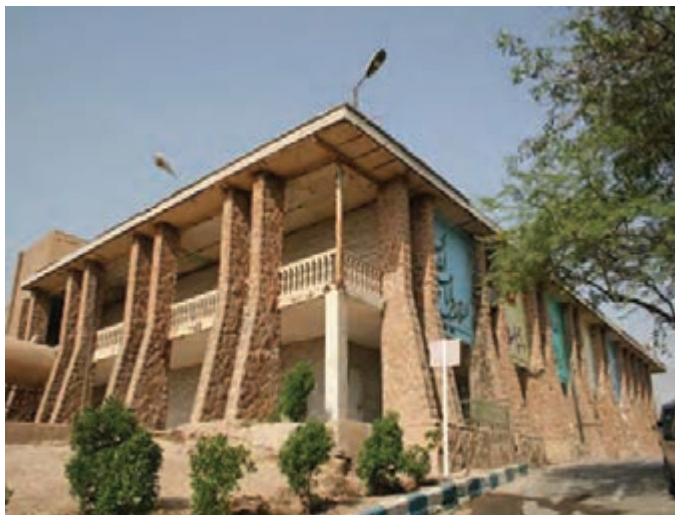
شکل ۳۰-۴. ساختمان گلف در اهواز
