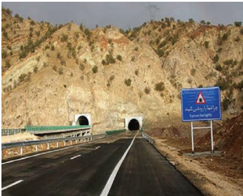
شکل ۱۲-۱۴ - آزادراه خرم‌آباد - پل زال
