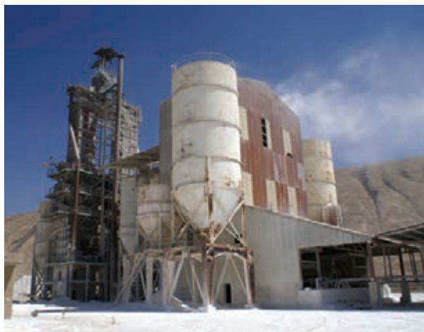
شکل ۳-۱۴- کارخانه آهک هیدراته پلدختر
