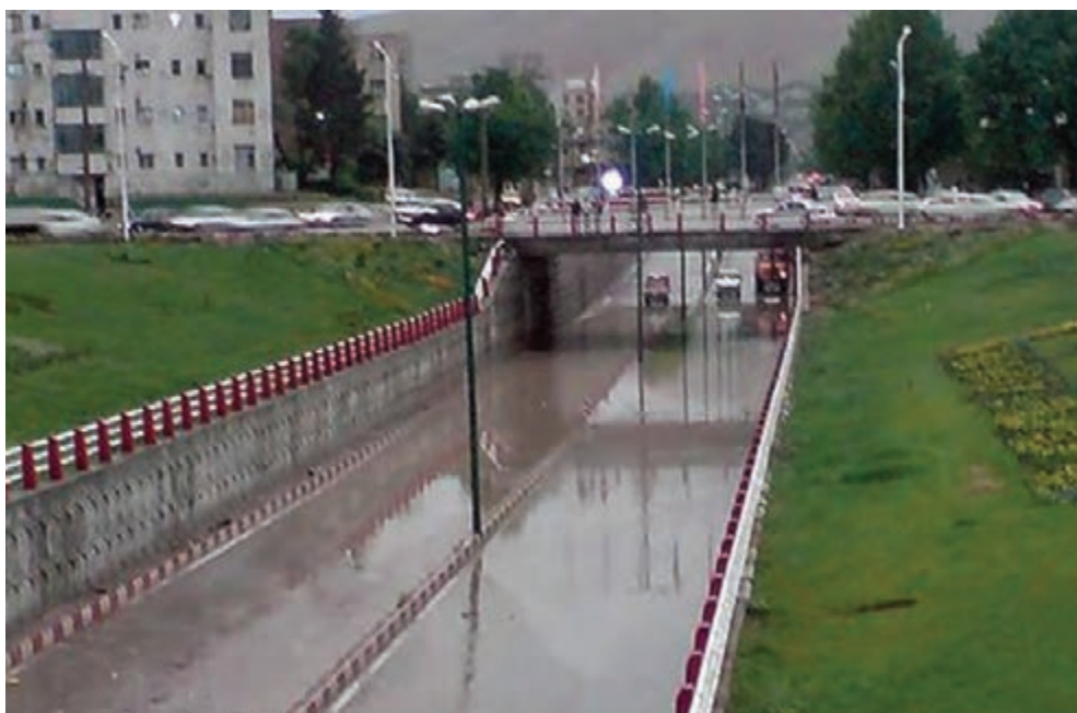
شکل ۱۰-۱۴- یکی از زیرگذرهای شهر خرم‌آباد
