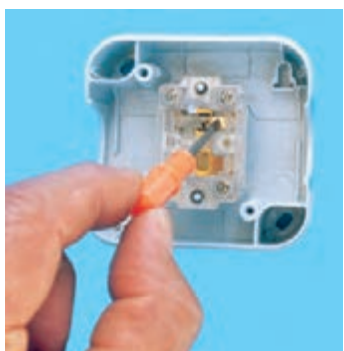
د - برقراری اتصال پلاتین با کنتاکت غیرمشترک ۲
