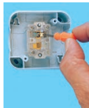
ج - برقراری اتصال پلاتین با کنتاکت غیرمشترک ۱
