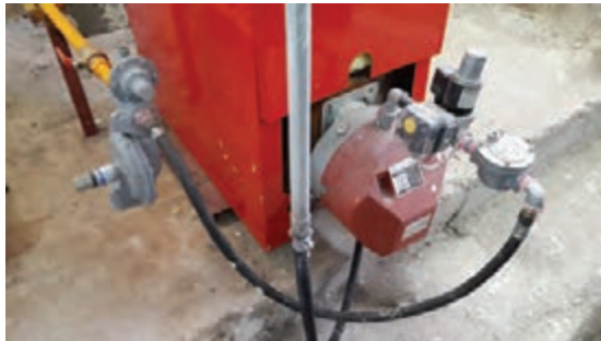
شکل ۲۹- اتصال مدار سوخت
