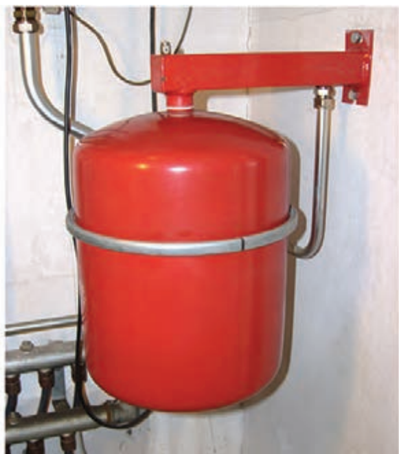
شکل ۱۶- استقرار مخزن انبساط بسته
