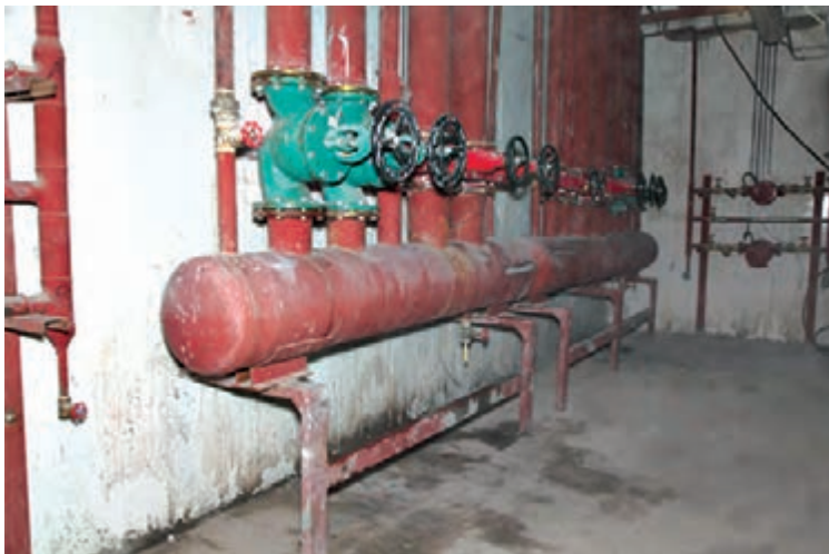
شکل ۱- نصب شیر تخلیه کلکتور
