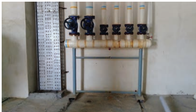
شکل ۲- نصب پایه کلکتور
