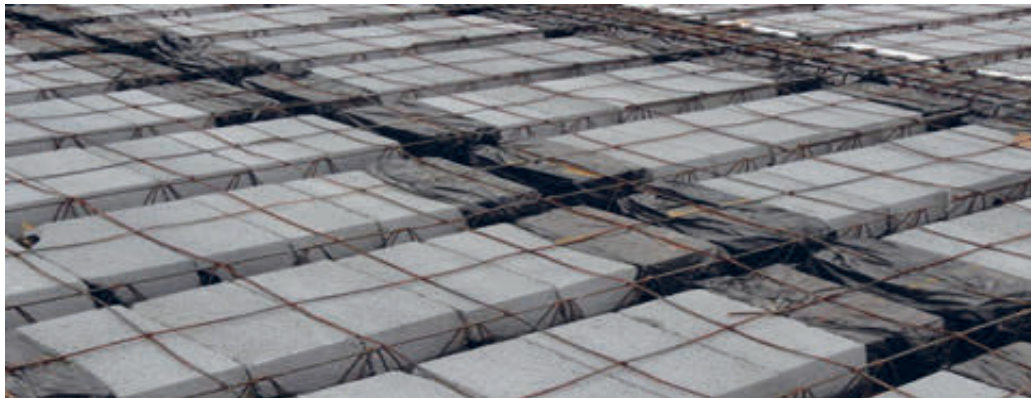
اجرای شناژ مخفی در سقف تیرچه بلوک
