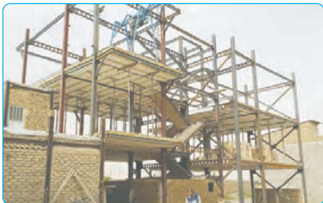
خانه‌ی در حال ساخت
