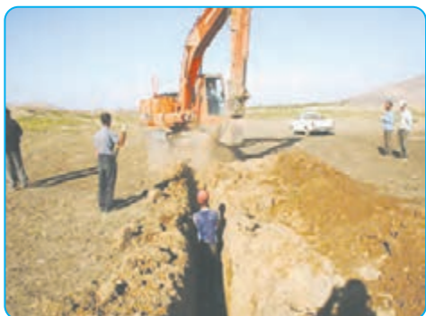
کندن زمین با بیل مکانیکی
