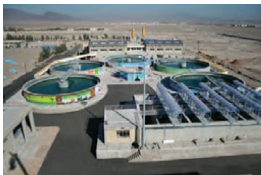
شکل ۱۳-۴ تصفیه خانه آب زاهدان
