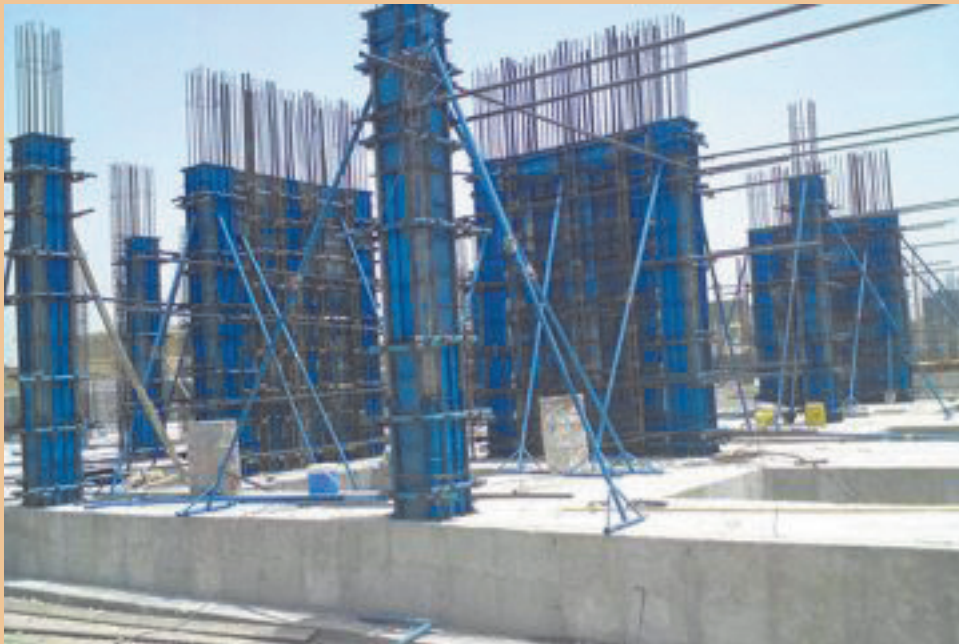
قالب‌بندی و آرماتوربندی ستون
