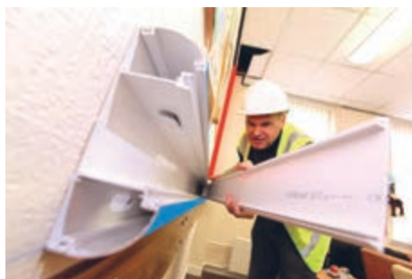
شکل ۴۳- نصب درپوش ترانکینگ
