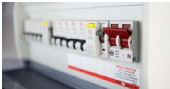
شکل ۷۹- تابلوی توزیع برق واحد مسکونی
