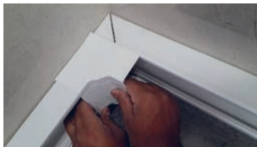
شکل ۵۱- نصب زانوی داخلی
