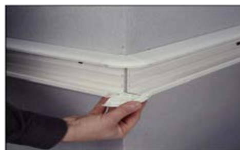
شکل ۴۴- نصب درپوش ترانکینگ زاویه دار
