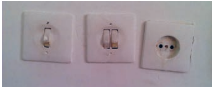
شکل ۱- نصب غلط کلید و پریز
