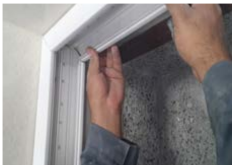
شکل ۵۰- برش و فارسی بر کردن ترانکینگ
