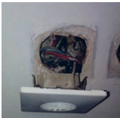
شکل ۳- قاب جداشده پریز از دیوار
