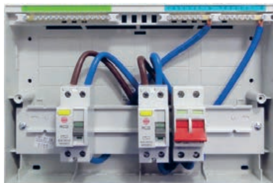
شکل ۴۷- سیم‌کشی قطعات تابلو
