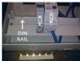
ب) قبل از نصب شین
