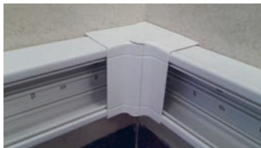
شکل ۵۱- نصب زانوی داخلی
