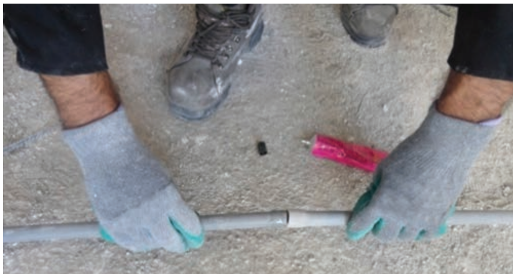
شکل ۴۵- اتصال لوله PVC
