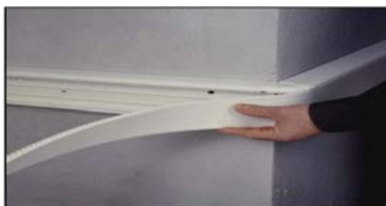
شکل ۴۴- نصب درپوش ترانکینگ زاویه دار
