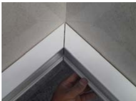
شکل ۵۰- برش و فارسی بر کردن ترانکینگ
