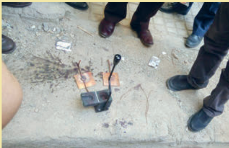
شکل ۹۸- رعایت فاصله از بوته مخصوص جوش اگزوترمیک
