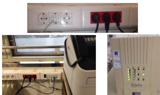
شکل ۱۶ - اتصال چند بار مختلف به UPS
