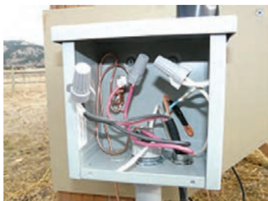
شکل ۳۵- اتصال میله مسی به بدنه تابلو اتصالات
