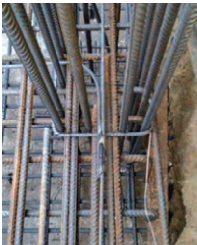
شکل ۲۲- جوشکاری میلگردهای شناژ با شالوده
