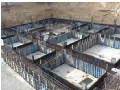
شکل ۵ – قبل از بتن‌ریزی (شالوده)
