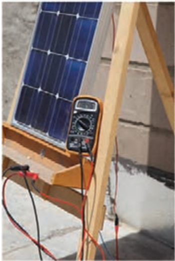
شکل ۱۵-۱- اندازه‌گیری ولتاژ بی‌باری
