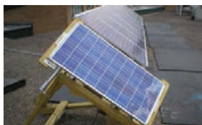
شکل ۵۳ - دو نمونه پایه و سازه پنل خورشیدی (فلزی و چوبی)
