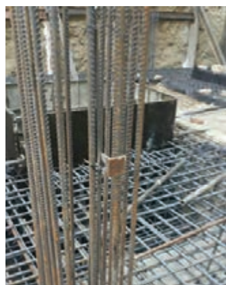
شکل ۲۷ - قطعه اتصال دهنده
