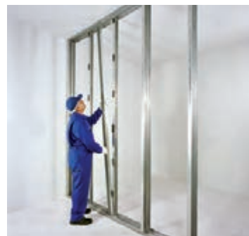
شکل ۸۴-۱- اجرای ردیف دوم استاداها شکل ۸۵-۱- زیرسازی تکمیل شده شکل ۸۶-۱- اجرای پانل ها در یک طرف دیوار
