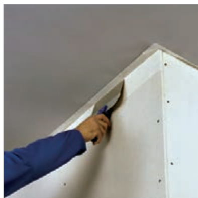
شکل ۳-۸۷- بتونه کاری در فصل مشترک دیوار خشک و سقف بتابی
