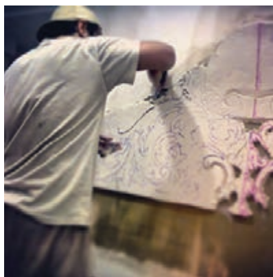
شکل ۳۵-۲ مراحل اجرای گچ‌بری به شیوه درجا
