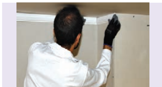
شکل ۲۳۲-۱ نصب قطعه نهایی
