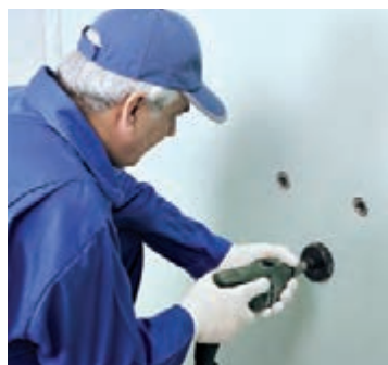
شکل ۱۰۲-۱- ایجاد خروجی تأسیسات به وسیله گرد بر
