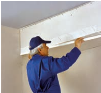
شکل ۸۴-۳- قرار دادن نوار درزگیر بر روی بتونه
