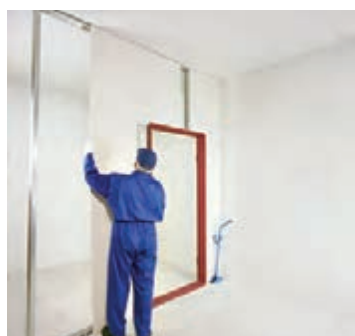
شکل ۱۳۸-۱ اجرای پانل اول دور چهارچوب
