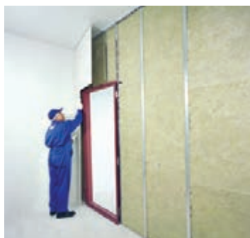
شکل ۱۴۱-۱ اجرای پانل سوم دور چهارچوب پس از عایق‌گذاری (پانل‌ها نسبت به سمت اول به شکل حصیرچین اجرا می‌شوند).
