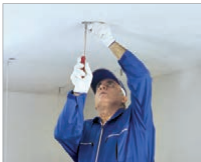
شکل ۳-۱۱۶ اتصال قطعه HT ۹۰ به سقف اصلی شکل ۳-۱۱۷
