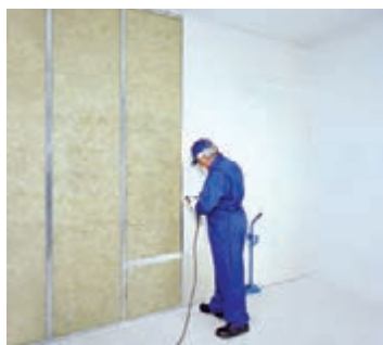
شکل ۱-۶۹- اجرای پانل‌ها در طرف دیگر دیوار
