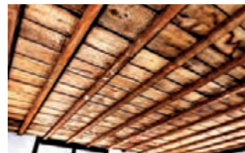
شکل ۳-۱- سقف کاذب چوبی
