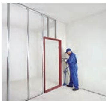
شکل ۱۳۸-۱ اجرای پانل اول دور چهارچوب
