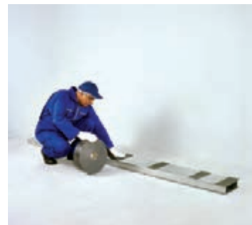
شکل ۱-۸۱- اجرای نوار عایق بر روی استادهای
