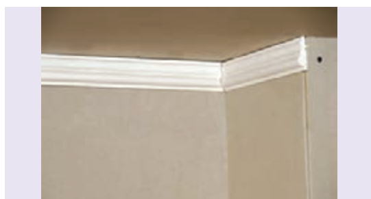
شکل ۲۳۳-۱ اتصال قطعات در کنج
