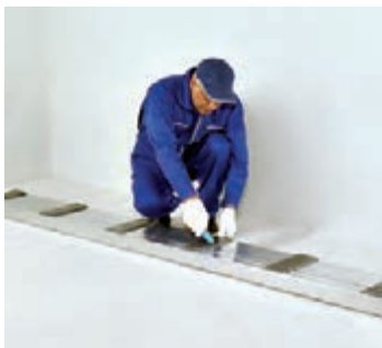
شکل ۱-۸۲- برش نوارهای عایق
