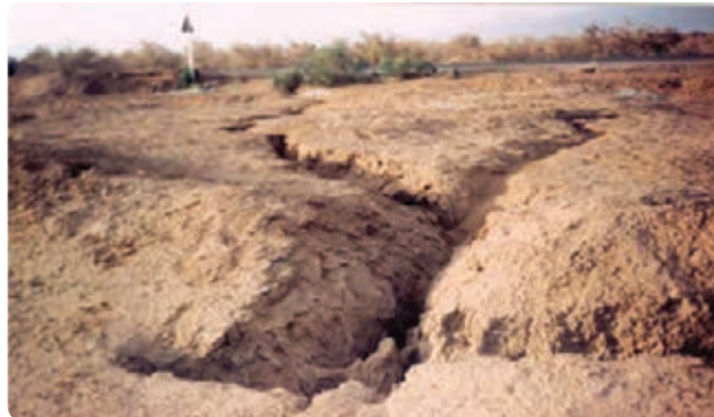
شکل ۵۴-۱ پدیده فرونشست در منطقه رضوان شهر
