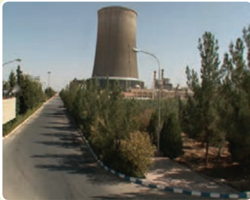
شکل ۱۰-۶- نیروگاه سیکل ترکیبی
